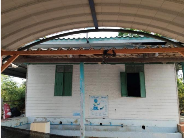
ภาพถ่ายด้านหน้าอาคาร
