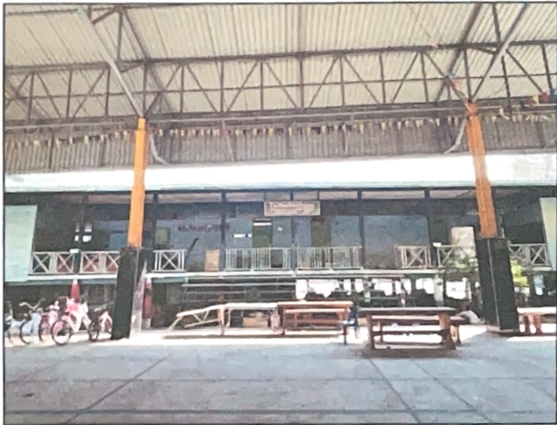
ภาพถ่ายด้านหน้าอาคาร
