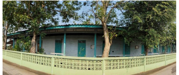
ภาพถ่ายด้านขวาอาคาร
