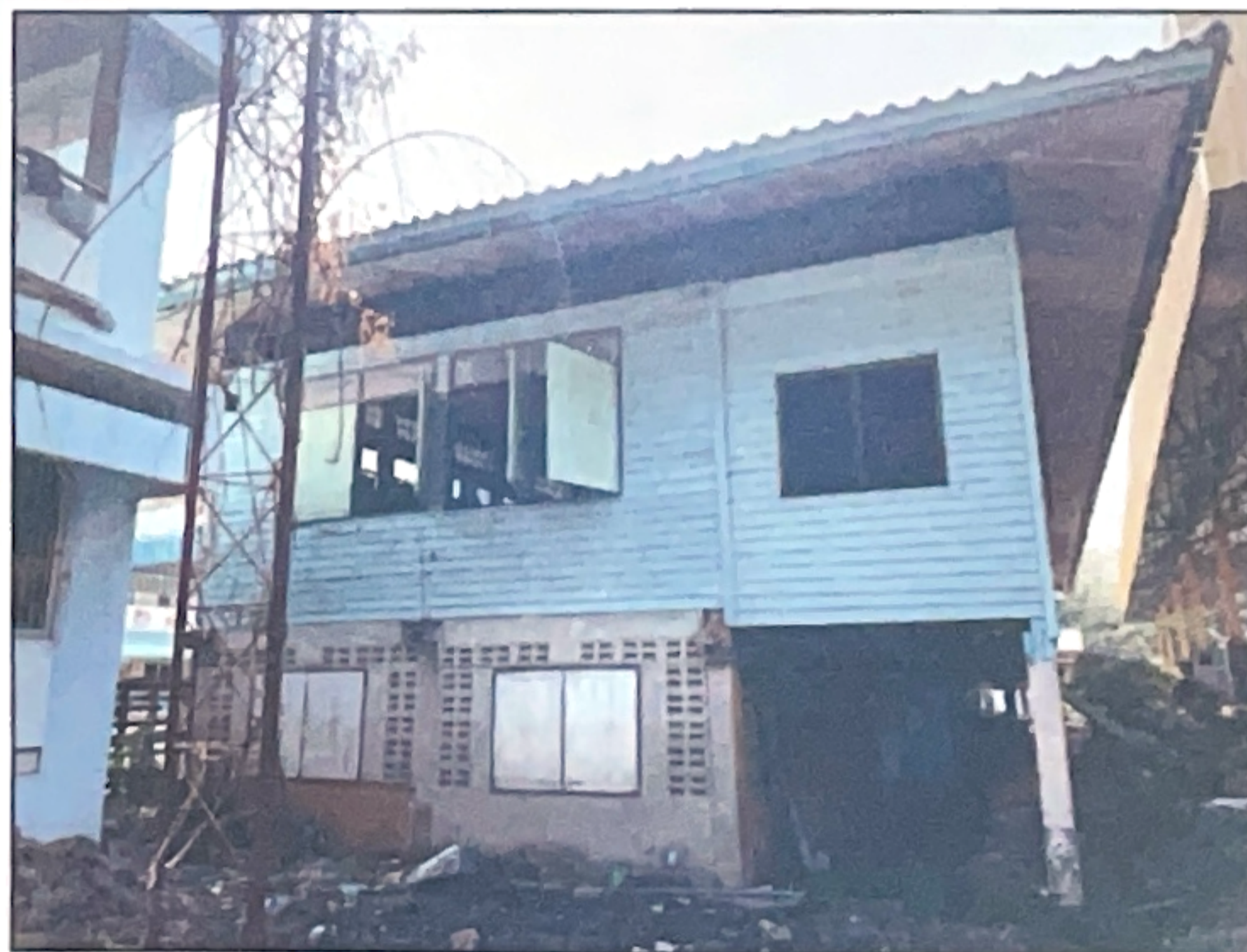
ภาพถ่ายด้านขวาอาคาร
