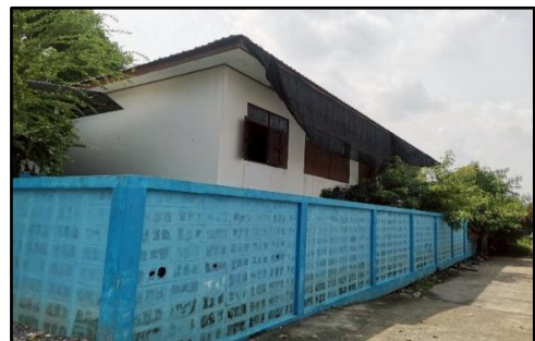
ภาพถ่ายด้านขวาอาคาร
