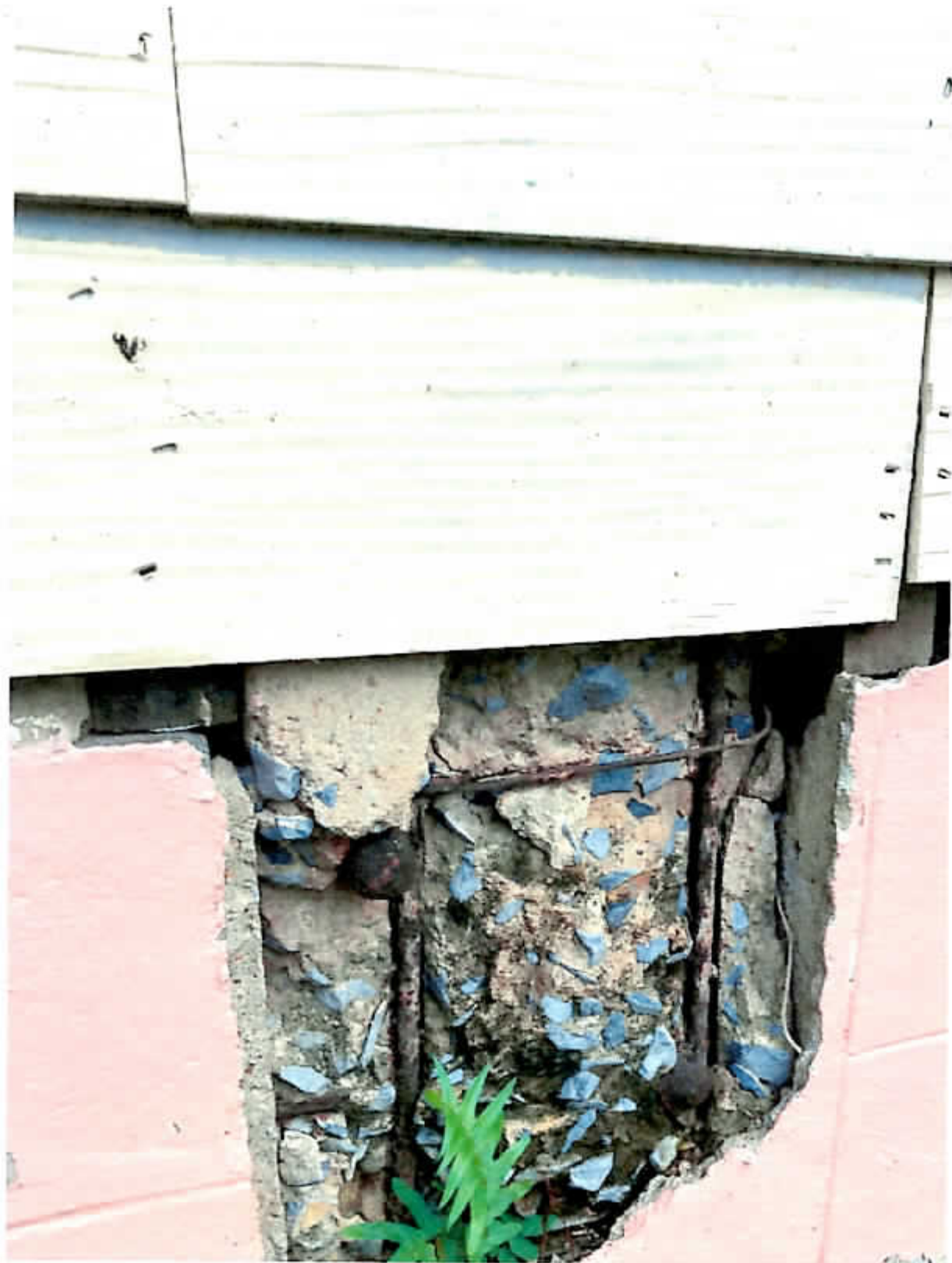
โครงสร้างเสาอาคารชั้น 1
